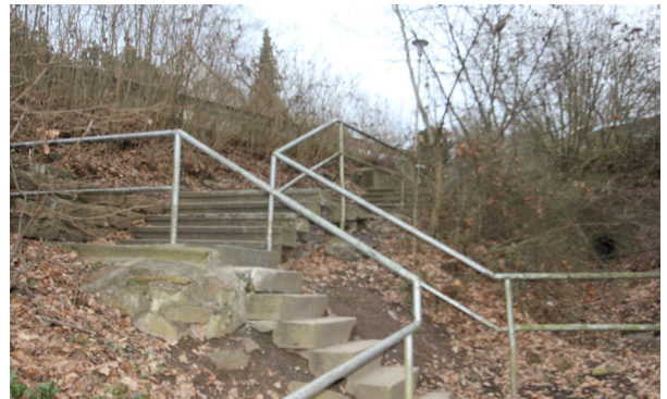
Bild: Treppenabgang Unterführung Bahn
