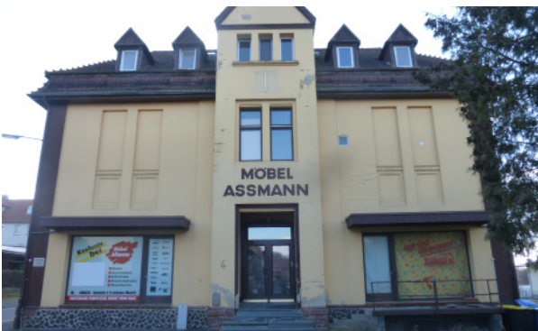
Bild: Gebäude Möbel Assmann
